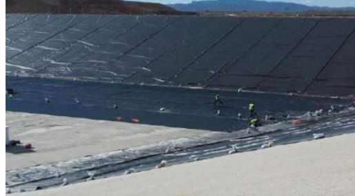
Sobre la lámina de PEAD se colocará un geotextil con objeto de ofrecer una protección adecuada frente a punzonamiento. Esta capa anti-punzonamiento estará formada por un geotextil de poliéster de 300 gr/m<sup>2</sup> de gramaje en los taludes y de 600 gr/m<sup>2</sup> de gramaje en el fondo y unión con celdas.
