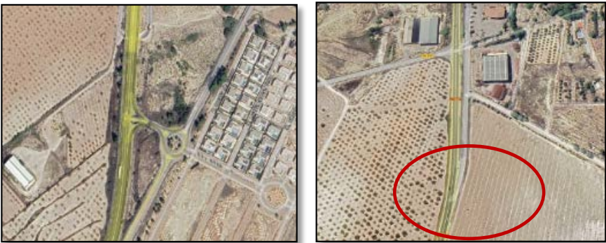
Vista rotonda que permite realizar el cambio de sentido. Vista acceso a instalación a través salida directa desde RM-714 a vía de servicio
