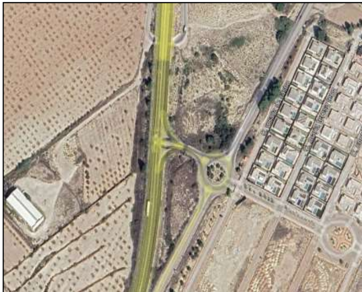
Vista rotonda que permite realizar el cambio de sentido
