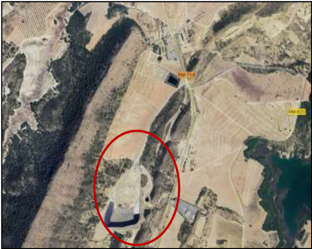
Vista aérea instalaciones existentes
