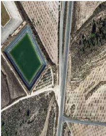
DETALLE 3 Enlace de vial de doble sentido (actualmente adaptado), que parte de la instalación, con vía de servicio (sentido carretera) que nos conduce, tal y como queda reflejado en los planos de detalle, hasta la R-714, en el cruce de Valentín.
