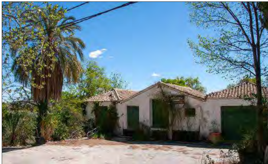
Fotografía 19. Molino de Sahajosa
